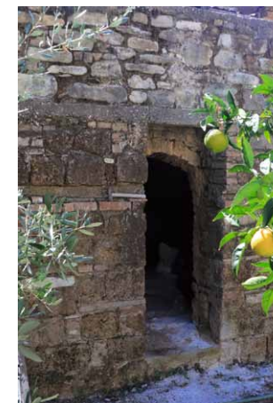
Ingang van de oude oven, die nu rust in de achtertuin tussen olijven en sinaasappelbomen
